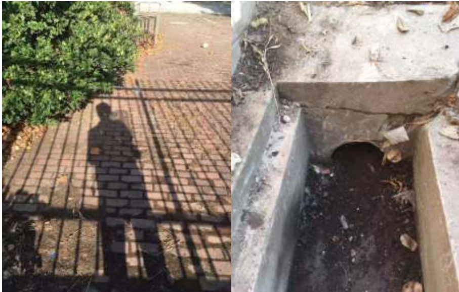
化粪池现场位置
